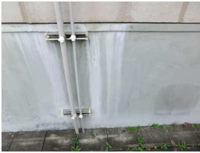
1号棟 西側外壁基礎 エフロ
