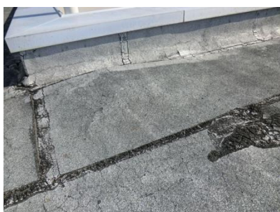
屋上 アスファルト防水 膨れ・目地劣化
