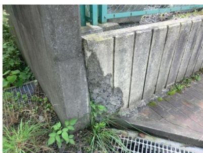
北側 擁壁化粧部 破損
