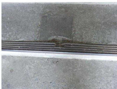
2号棟 西側階段 滑り止め 破損
