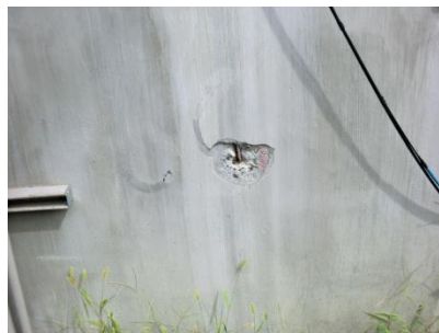
3号棟 西側基礎 鉄筋露出
