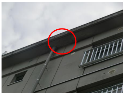
1号棟 外壁軒裏 塗装剥離
