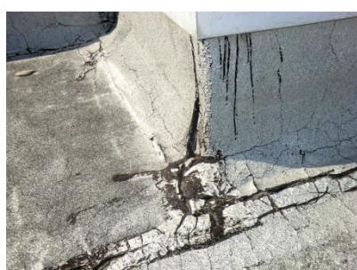
屋上 アスファルト防水 目地ひび割れ
