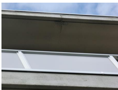
3号棟 南側外壁 ひび割れ
