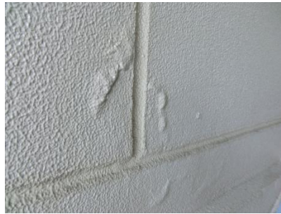
1号棟 東側階段 塗装浮き・膨れ
