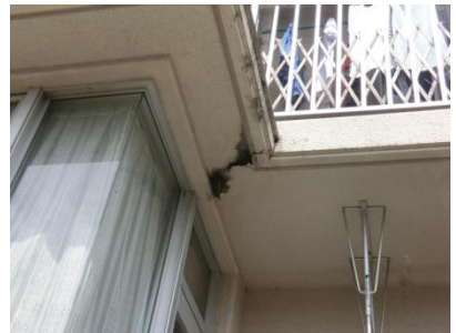
2号棟 南側外壁 ひび割れ・汚れ
