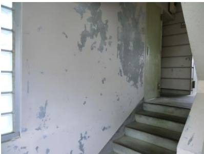
2号棟 西側階段 塗装剥離
