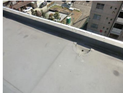
2号棟 屋上 防水シート ひび割れ
