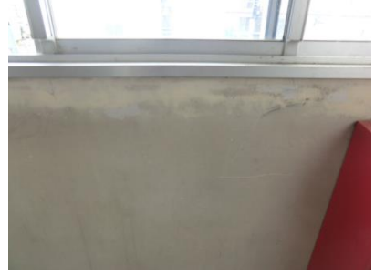
1号棟 東側階段 塗装剥離
