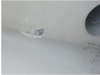
1号棟 西側階段 塗装剥離
