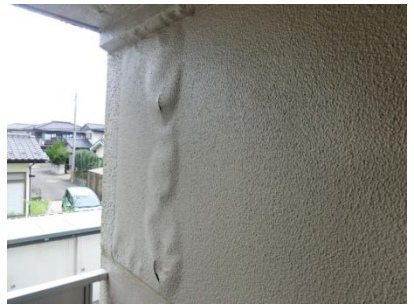
2号棟 東側階段 塗装浮き・膨れ
