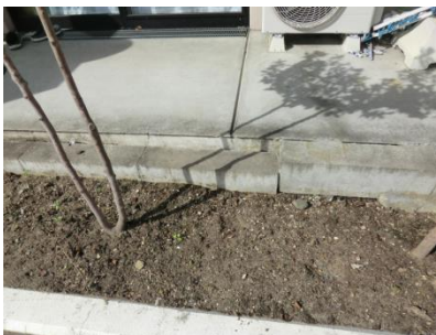
6号棟 南側ブロック 沈み
