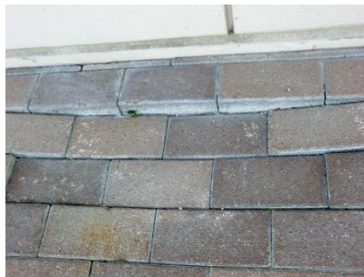
5号棟 北側通路 タイルの沈み
