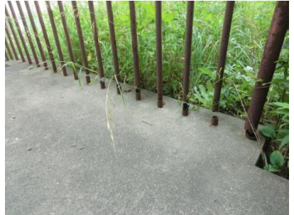
南側外部階段手すり 腐食・破損
