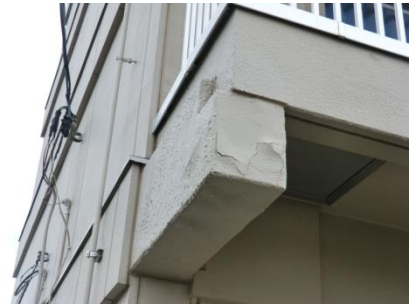
2号棟 南側外壁 塗装剥離・ひび割れ
