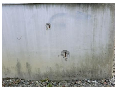
2号棟 北側基礎 鉄筋露出
