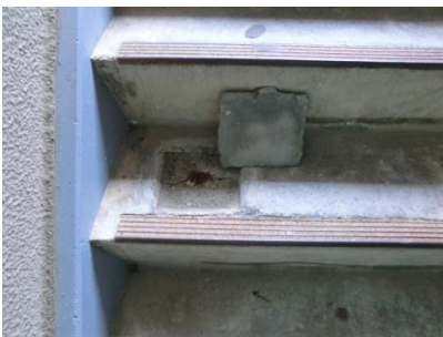
2号棟 東側階段 床破損
