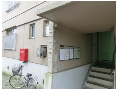
2号棟 東側階段 塗装浮き・剥離
