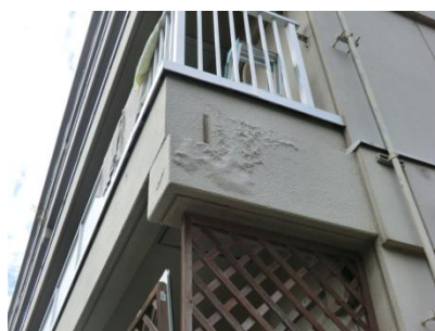
2号棟 東側外壁 塗装浮き・膨れ
