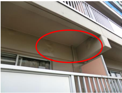
2号棟 南側外壁 塗装浮き
