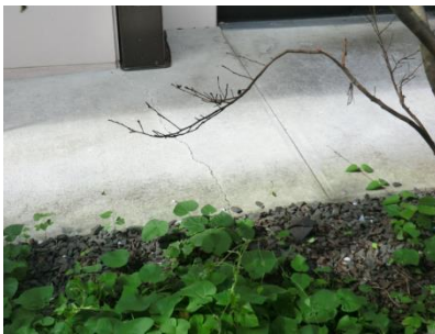
4号棟 バルコニー床 ひび割れ
