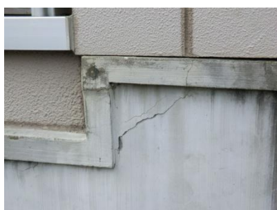
2号棟 東側基礎 ひび割れ
