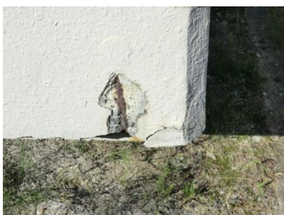
南側外壁 爆裂による鉄筋露出
