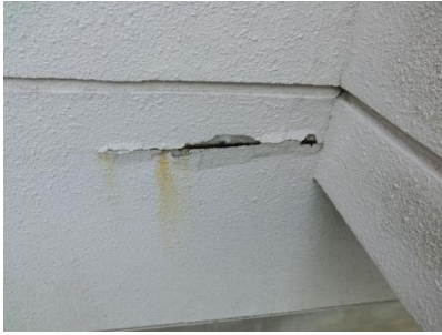
1号棟 北側外壁 鉄筋露出
