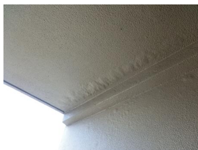
4号棟 東側階段 天井 塗装浮き
