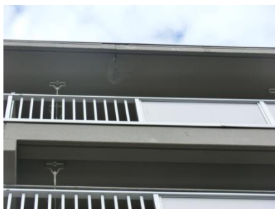
1号棟 外壁軒裏 ひび割れ
